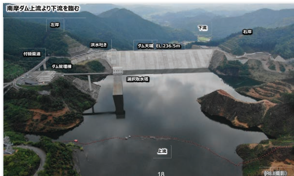
南摩ダム(提供：水資源機構)
