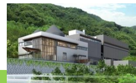
バイオマス発電所
