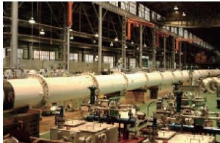
ラスベガス（アメリカ） ※取水ポンプ
