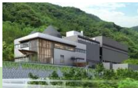
バイオマス発電所
