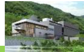
バイオマス発電所
