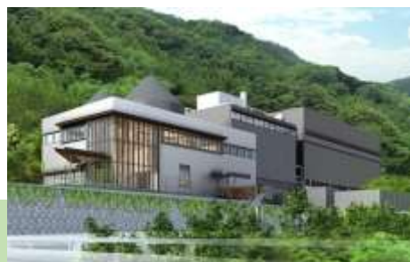
バイオマス発電所
