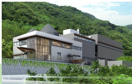
バイオマス発電所
