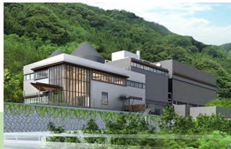
バイオマス発電所
