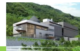
バイオマス発電所
