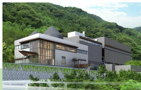
バイオマス発電所
