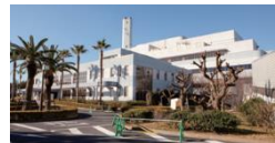
流動床炉を備えた ごみ焼却施設
