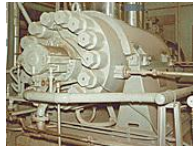
国産初の超臨界圧力用 給水ポンプ
