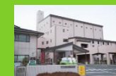
設計・建設から 運営・維持管理まで 一括で受注した ごみ焼却施設第1号
