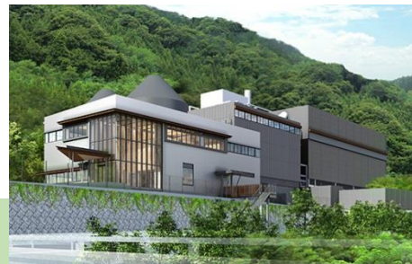
バイオマス発電所
