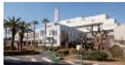
流動床炉を備えた ごみ焼却施設
