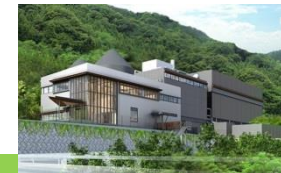
バイオマス発電所
