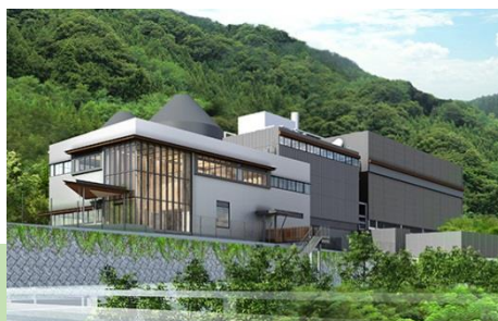
バイオマス発電所
