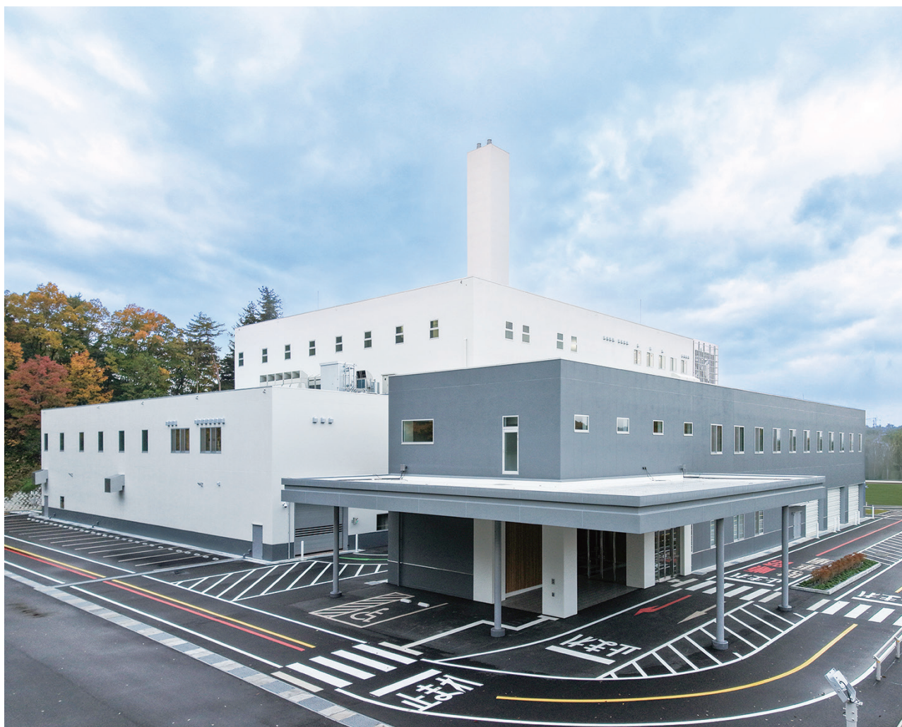
高山市資源リサイクルセンターの全景。今年2月の供用開始以来、安定稼働が続く
