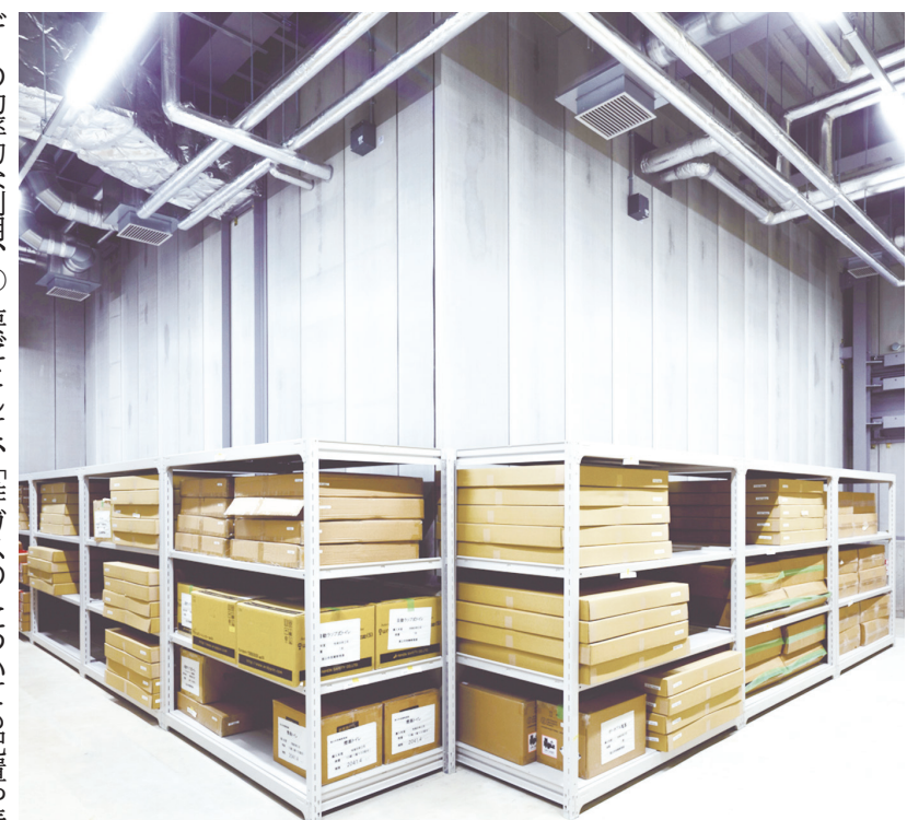
高山市の指定避難所となり、防災備蓄庫も設置している
