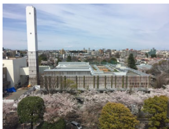
発電設備を有するごみ焼却施設 (武蔵野クリーンセンター)
