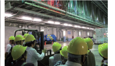
今回の見学会では特別に、ごみ収集車が集めてきたごみをピットへ投入するプラントホームも見学しました
