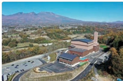
廃棄物焼却プラント
