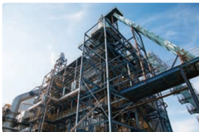
バイオマス発電プラント
