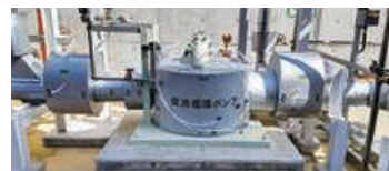
燃料アンモニア転換実証 火力発電所での液体アンモニア用 キャンドポンプの試運転に成功
