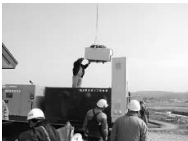
写真4 排水ポンプ吊り上げ状況 Photo 4 Installation of pump by crane
