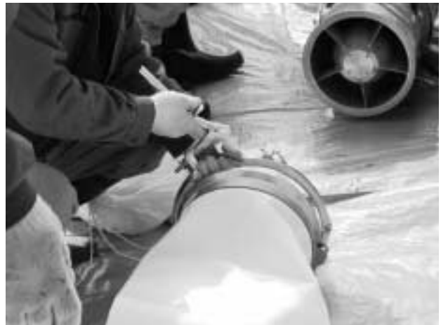
写真5 排水ホース接続状況 Photo 5 View of drain hose connection
