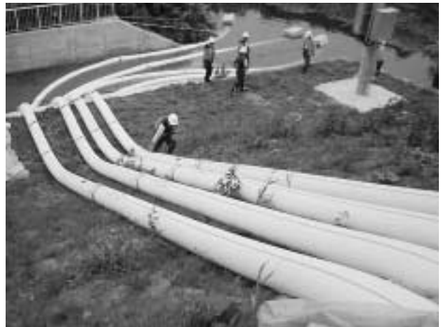
写真6 排水ポンプ運転状況 Photo 6 View of drain pump operation
