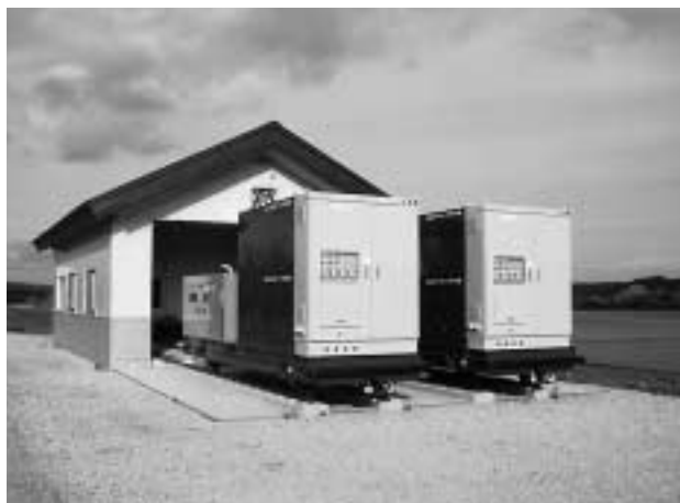
写真1 排水ポンプユニットと格納庫 Photo 1 Drain pump unit and drain pump unit house
