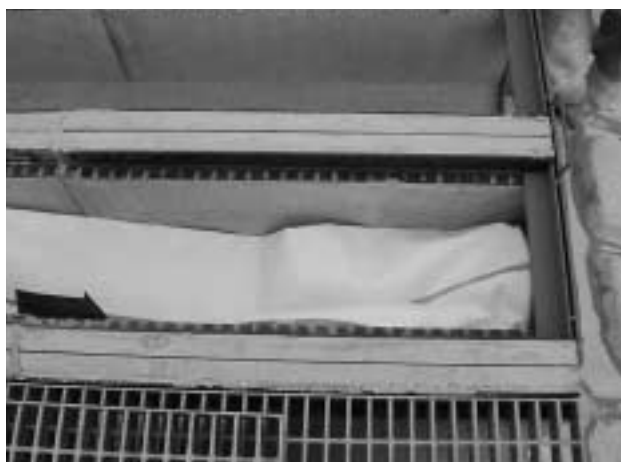
写真3 U字トラフへの排水ホースセット状況 Photo 3 Drain hose in U trough
