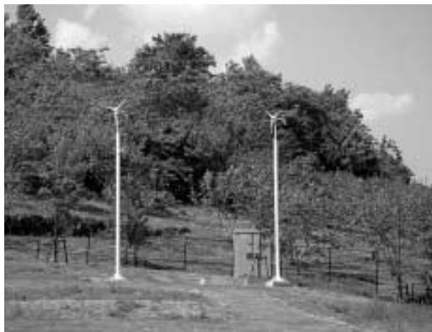
写真4 小型風力発電機，制御盤 Photo 4 Small-scale wind power generators & control panel
