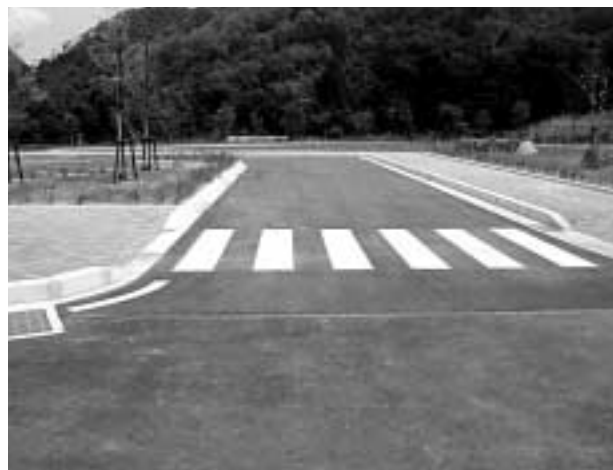
写真2 スラグを利用した舗装道路
