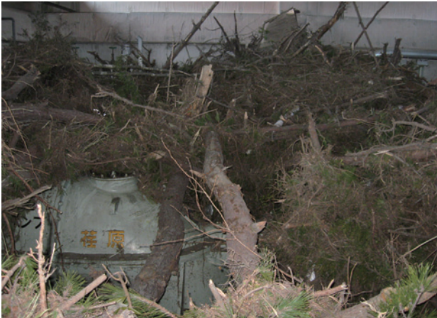
写真3 震災直後の福島県新田排水機場内部 (2011年4月撮影 左下口径1350 mm 横軸軸流ポンプ)
