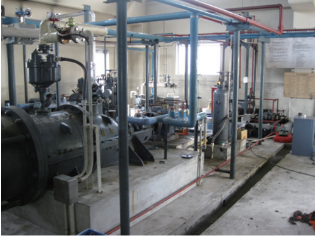
写真7 応急復旧後の福島県和田排水機場（2011年6月撮影 手前1号機を応急復旧） ※早期復旧のためポンプ駆動機を既設エンジンから モータ駆動に変更
