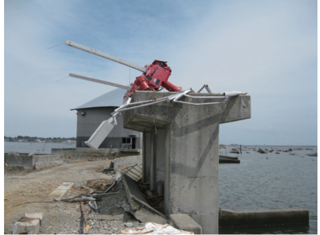
写真5 震災直後の福島県新田排水機場吐出しゲート (2011年4月撮影)
