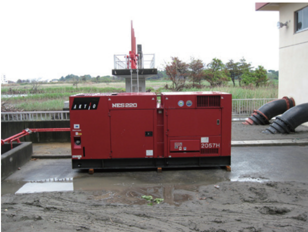
写真8 応急復旧後の福島県和田排水機場（2011年6月撮影） ※電力未復旧のためレンタル発電機（日本車両製造(株)製） をポンプ電源とした。
