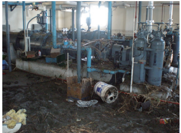
写真6 震災直後の福島県和田排水機場内部 (2011年4月撮影)
