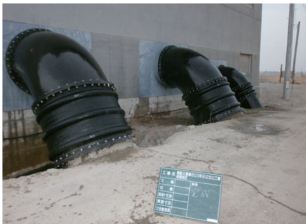
写真9 相馬排水機場 主ポンプ用ゴム可撓管本復旧完成写真 (2013年2月撮影)
