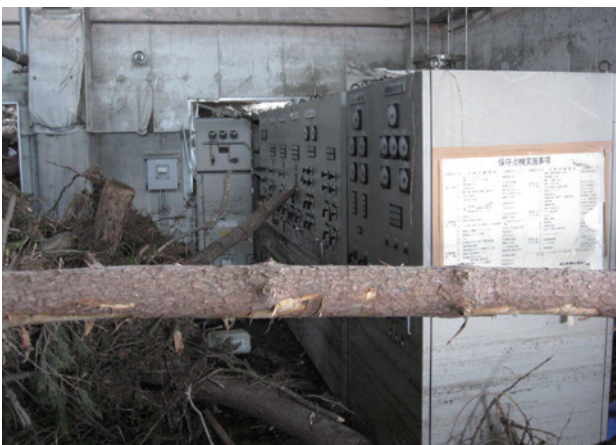
写真4 震災直後の福島県新田排水機場内部 (2011年4月撮影)
