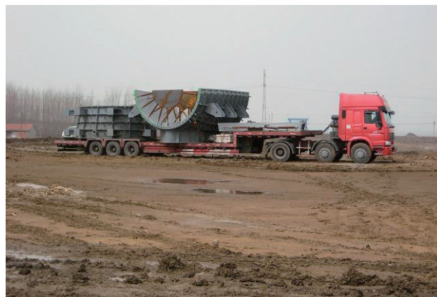
写真4 ポンプケーシング搬入 Photo 4 Transporting the pump outer casing
