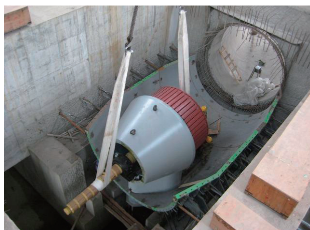
写真5 ロータ据付中 Photo 5 Installation of the motor rotor
