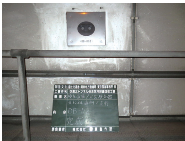
写真3 火災検知器 Photo 3 Fire detector
