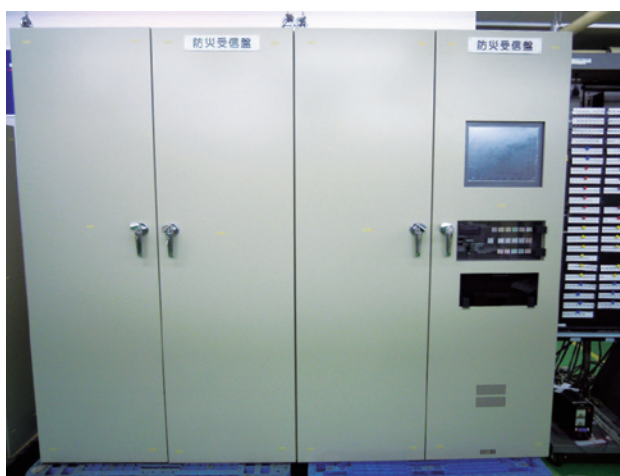
写真5 防災受信盤（空港北トンネル） Photo 5 Transmission unit (Airport North Tunnel)
