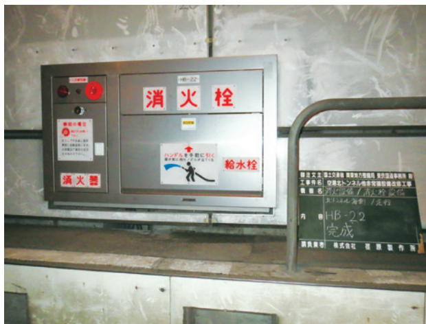
写真1 消火栓設備（消火器併設型） Photo 1 Fire hydrant
