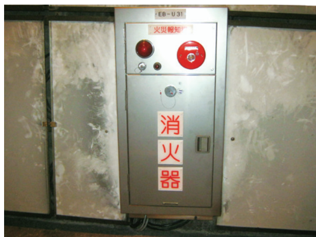
写真2 消火器設備 Photo 2 Fire extinguisher box
