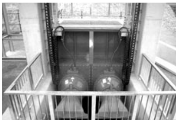
写真1 ポンプゲート据付外観
