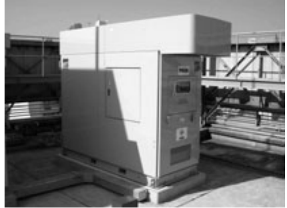
写真25 マイクロガスタービン発電装置 Photo 25 Micro gas turbine package
