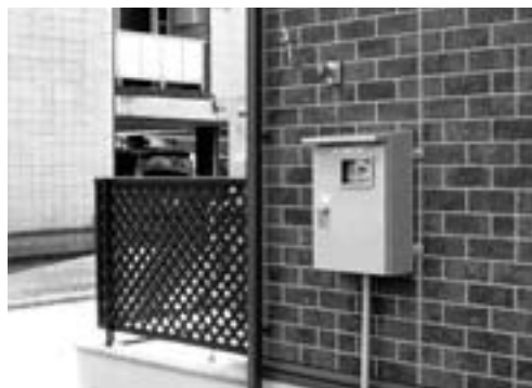
写真4 設置状況 Photo 4 Installation of control panel
