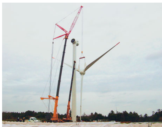
写真3 風車据付工事
