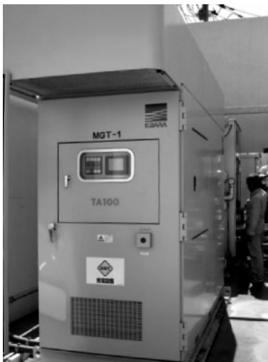
写真25 常用・非常用兼用マイクロガスタービンコージェネレーションシステム
