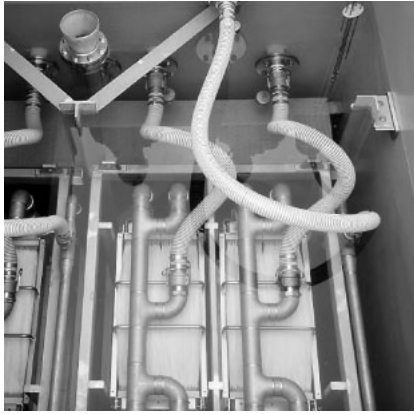
写真32 浸漬型膜ろ過装置
