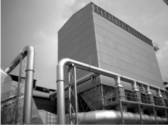
写真16 電炉集塵設備のバグフィルタ室
