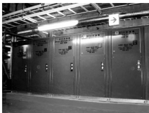
写真1 ヒートポンプ Photo 1 Heat-pumps
