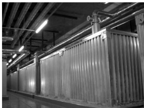
写真2 コンテナ型水蓄熱槽 Photo 2 Ice storage tanks
