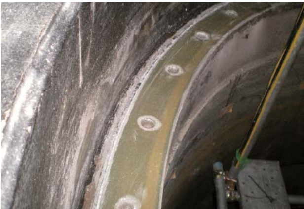
写真6 セルフレベル施工後のベース面 Photo 6 Surface of the pump base after self-leveling
